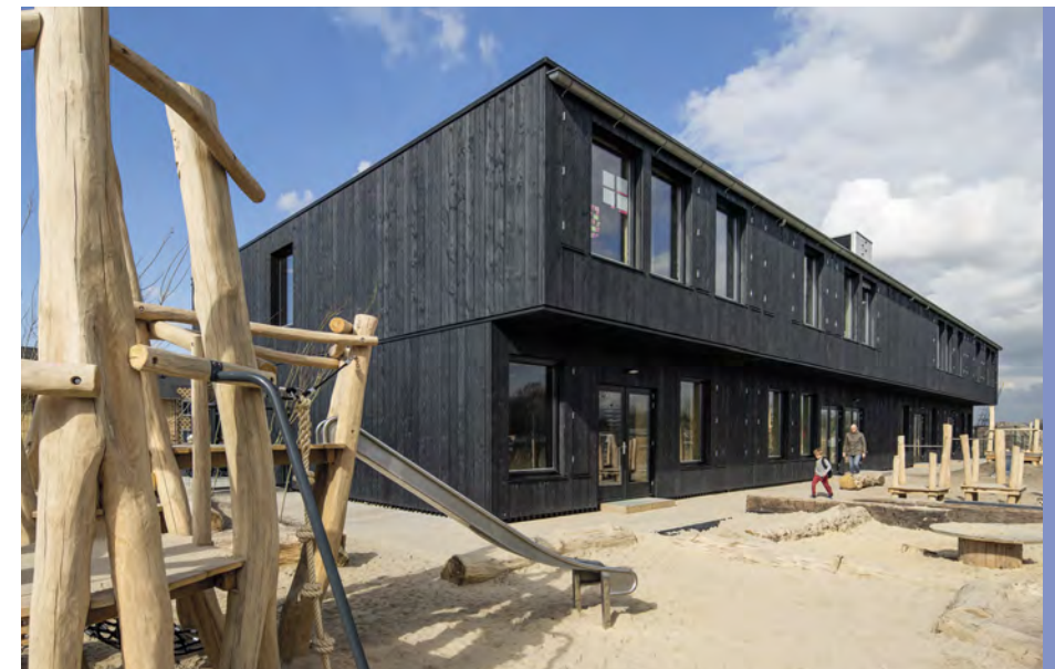
De tijdelijke school Nieuw Amsterdam (SeArch) bestaat uit CLT-modules die over vijf jaar worden gedemonteerd op een nieuwe locatie opnieuw worden opgebouwd.
