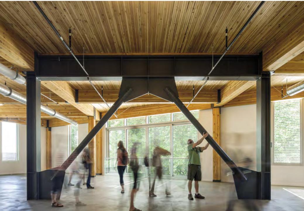
De combinatie van hout met staal in het Bullitt Center in Washington (Robert Hull).
