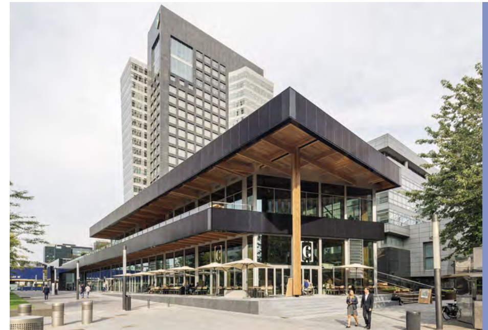
In het Circl paviljoen in Amsterdam (Architecten Cie.) zijn de glulam-balken demontabel en overgedimensioneerd, waardoor bij einde levensduur de balken met commerciële maten vrijkomen. De leverancier (Derix) heeft aangegeven de balken terug te willen nemen.
